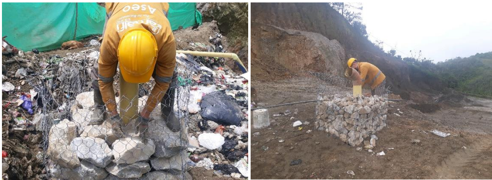
Imagen 7. Construcción de chimeneas de desfogue
