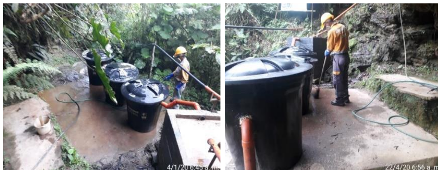
Imagen 5. Sistema de tratamiento de lixiviado
