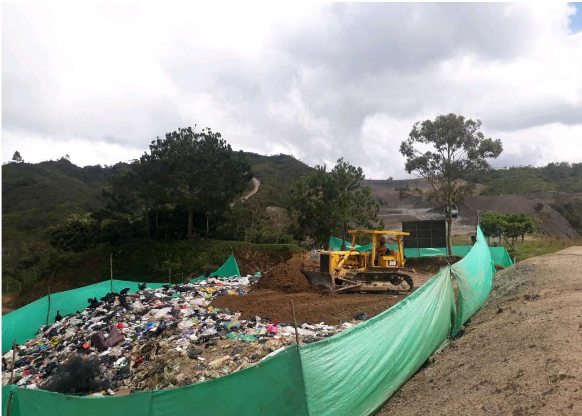
Imagen 3. Conformación y compactación de la celda diaria
