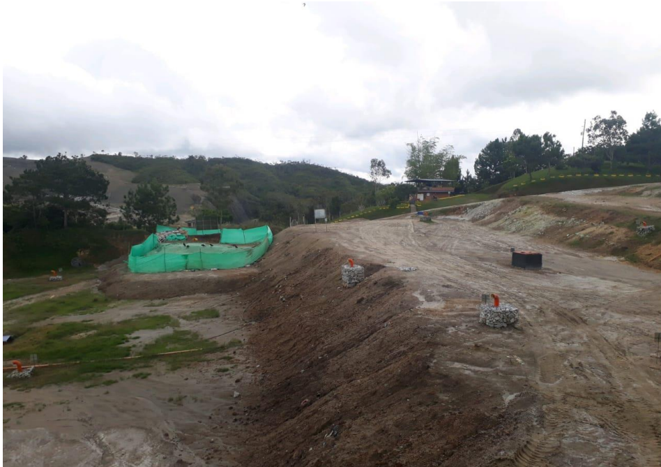
Imagen 2. Plataforma de descargue
