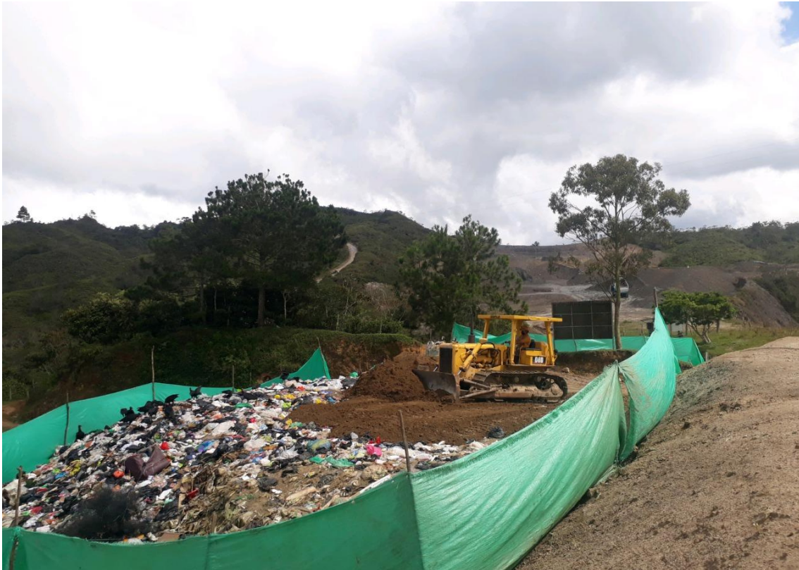
Imagen 3. Conformación y compactación de la celda diaria
