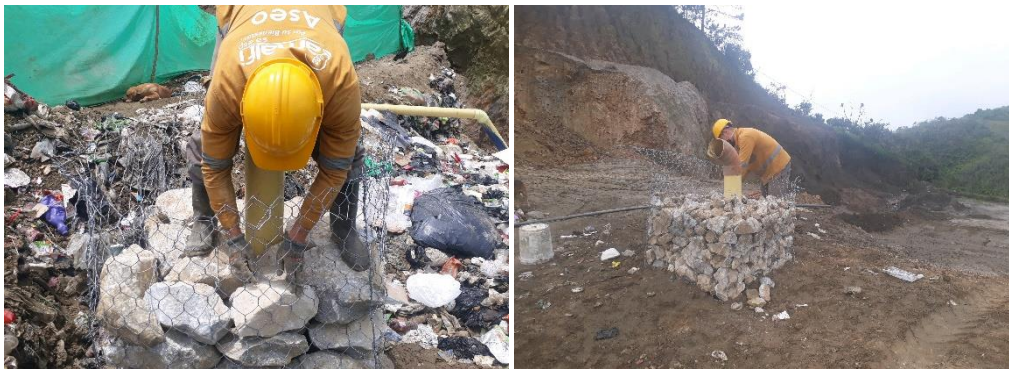
Imagen 7. Construcción de chimeneas de desfogue
