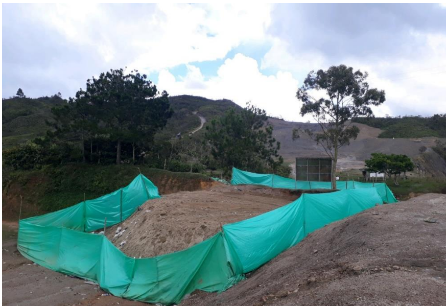
Ilustración 2. Conformación de la celda
